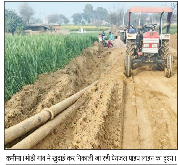
कनीना। मोड़ी गांव में खुदाई कर निकाली जा रही पेयजल पाइप लाइन का दृश्य।
